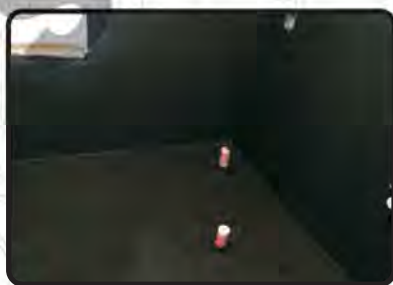
浴廁防水面塗施做
