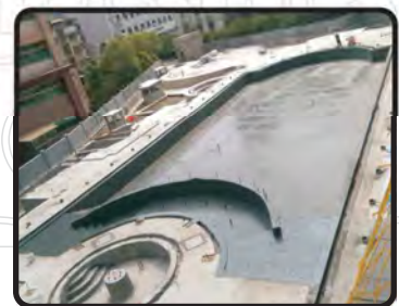
中庭景觀水池施做全景
