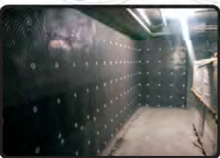
地下室導水版施做
