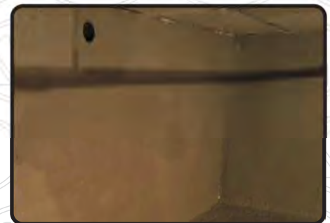
筏基坑防水施作
