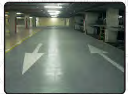
EPOXY地坪施作
